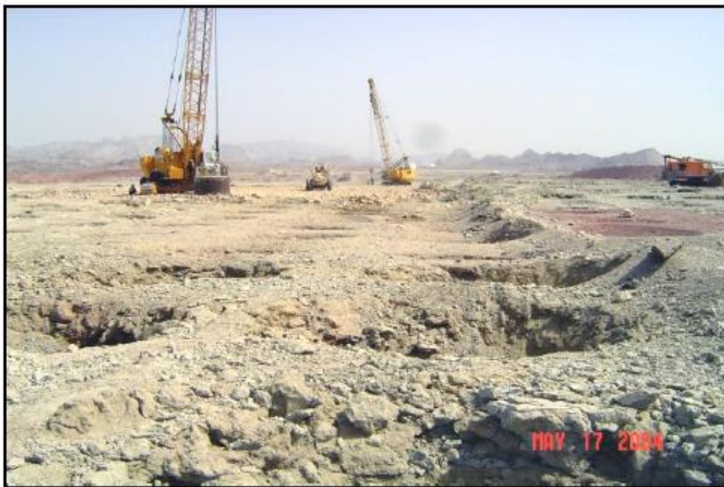
شکل شماره ۵: تصویری از انجام عملیات تراکم دینامیکی در منطقه عسلویه
